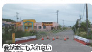
我が家にも入れない封鎖フェンス
